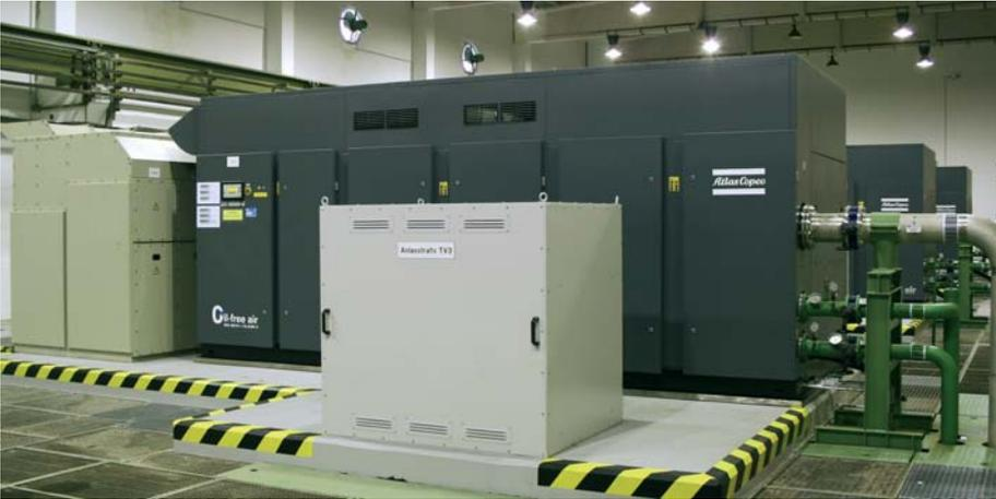
Die Entscheidung fiel auf Atlas Copco, mit **drei Turbokompressoren des Typs ZH 15 000**. Jeder einzelne erzeugt bis zu 14 500 m<sup>3</sup>/h, im Normalfall laufen nur zwei, der dritte fängt Spitzenlasten ab und dient vorrangig als Sicherheitsreserve. Gefahren wurde zuletzt mit einem Sollwert von **6,9 bar Betriebsüberdruck** mit einer **Schwankungsbreite von nur ± 0,15 bar**.
