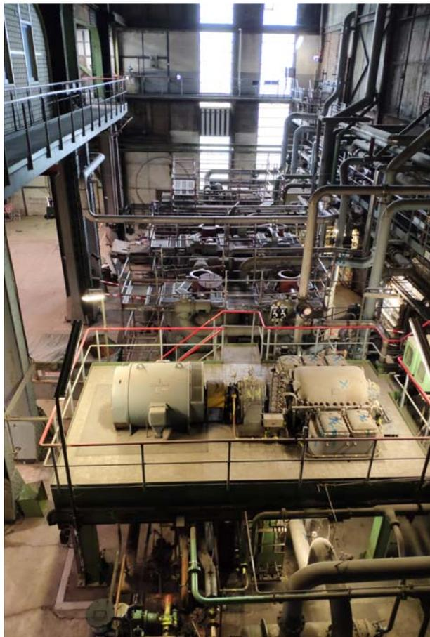
*Die alte Druckluftstation stand zum Zeitpunkt der Reportage noch, sollte kurz danach aber demontiert werden. In der Mitte erkennt man an den vier offenen runden Flanschen die vier ehemaligen Drucklufttrockner. Im Vergleich zu den neuen Adsorptionstrocknern sehen sie heute unfassbar groß aus – waren aber vor 50 Jahren Stand der Technik. (Bild: Atlas Copco/Thomas Preuß)*
