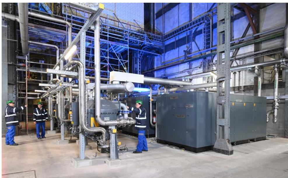
*Die Druckluft wird bei OQ Chemicals neuerdings von drei ZH<sup>+</sup>-Turbokompressoren von Atlas Copco erzeugt. Drei Drehtrommeltrockner (links im Bild) bereiten die Druckluft zu höchster Qualität auf. (Bilder: Atlas Copco/Henning Scheffen)*
