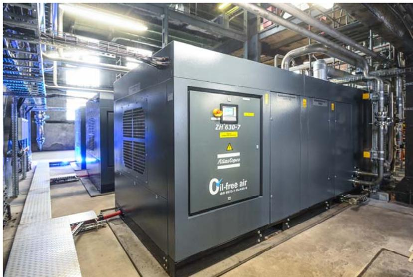
*Die Turbokompressoren der ZH<sup>+</sup>-Serie erzeugen sehr effizient große Mengen Druckluft und sind für den zuverlässigen Dauerlauf ausgelegt. OQ Chemicals hat drei Kompressoren aufgestellt, von denen immer nur zwei laufen. So kann der dritte einspringen, falls eine Maschine einmal gewartet werden sollte. (Bilder: Atlas Copco/Henning Scheffen)*
