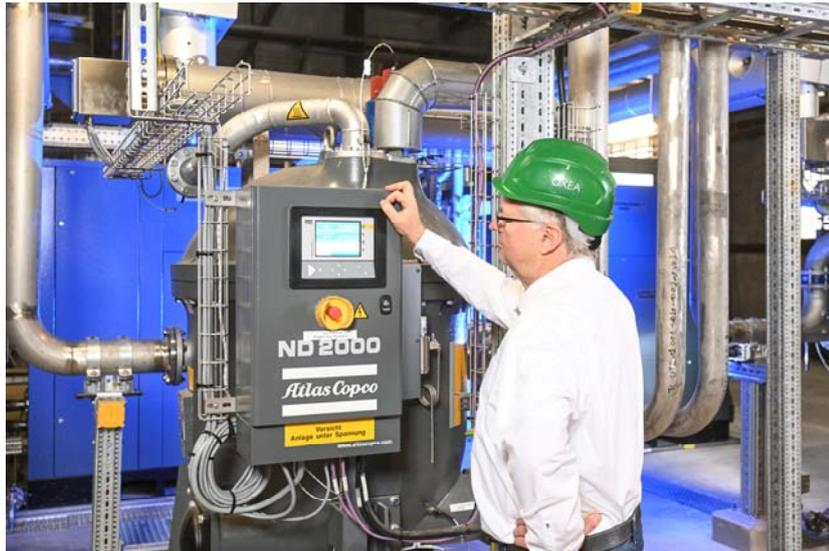
*Die ND-2000+-Drehtrommeltrockner senken den Drucktaupunkt auf -40 °C. Der niedrige Taupunkt war von OQ Chemicals angestrebt worden, um auch im Winterbetrieb zu vermeiden, dass die Feuchtigkeit im weit verzweigten Rohrleitungsnetz kondensiert. (Bild: Atlas Copco/Henning Scheffen)*
