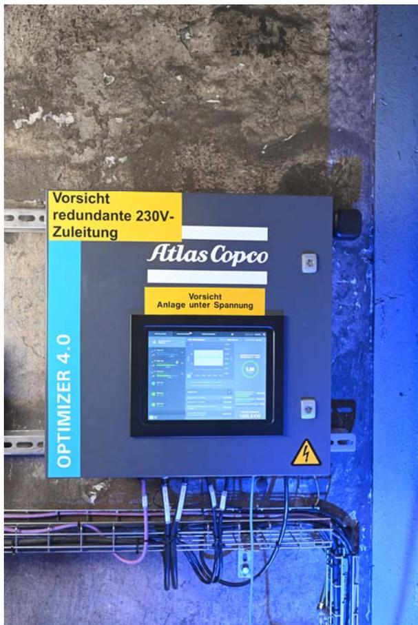
*Als übergeordnete Steuerung hilft der neue Optimizer 4.0 von Atlas Copco dabei, die drei Turbokompressoren in jedem Lastpunkt effizient zu betreiben. Außerdem bietet er vor Ort eine gute Anlagenübersicht und sammelt die Warn- und Störmeldungen der drei Kompressoren und der drei Trockner. (Bilder: Atlas Copco/Henning Scheffen)*
