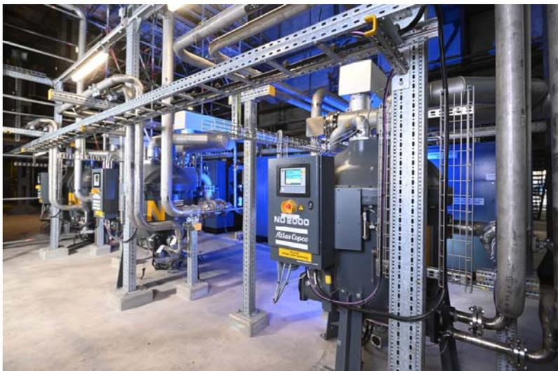
*Die ND-2000<sup>+</sup>-Drehtrommeltrockner arbeiten nach dem Heat-of-Compression-Verfahren: Sie nutzen die bei der Verdichtung entstehende Wärme, um das feuchte Trockenmittel zu regenerieren. Durch diesen effizienten Prozess kommen die Trockner nahezu ohne fremde Energie aus. (Bild: Atlas Copco/Henning Scheffen)*
