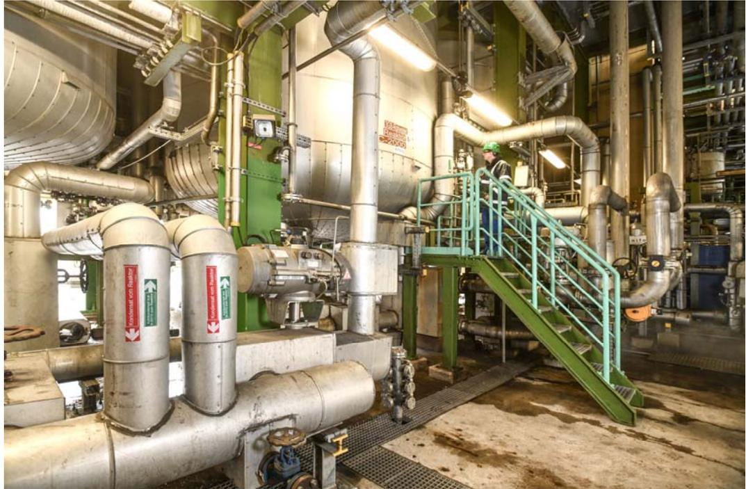
*Die Armaturen der chemischen Anlagen, im Bild ein Rohester-Reaktor, werden mit Druckluft gestellt. Wegen des weitverzweigten Leitungsnetzes auf dem Gelände setzt OQ Chemicals auf Druckluft mit einem besonders niedrigen Drucktaupunkt. (Bild: Atlas Copco/Henning Scheffen)*
