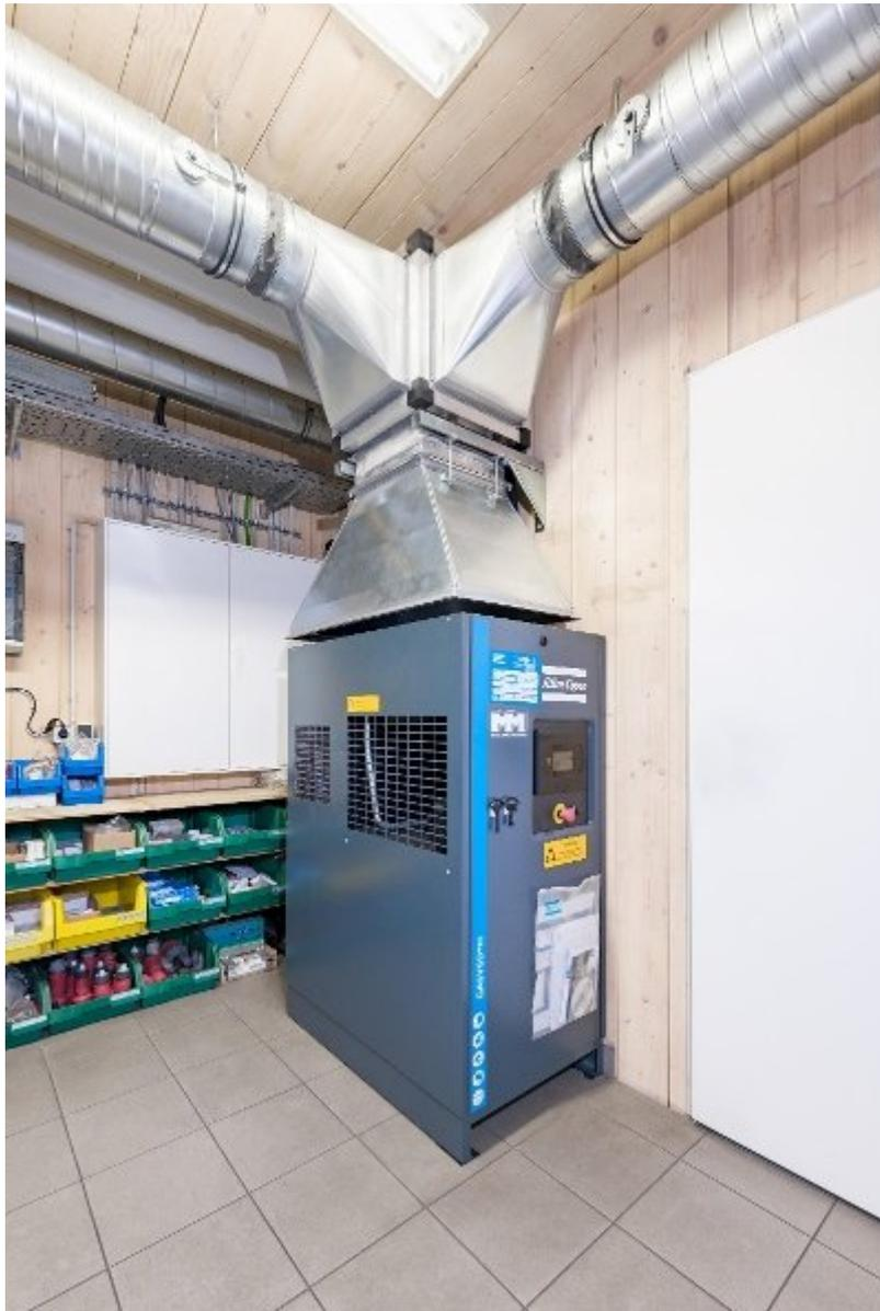
Bild 4: Der kleinste Schraubenkompressor von Atlas Copco mit variabler Drehzahlregelung liefert 5 KW Leistung und arbeitet mit gerade mal 62 dB(A) besonders leise und benötigt nur wenig Platz in der Werkstatt. Zudem ist der BAFA-Förderfähig.
