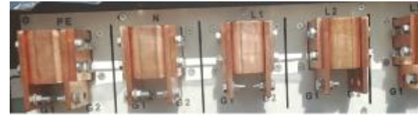
Jeu de Barres + CABLES OUTPUT COMMON BUS BAR
