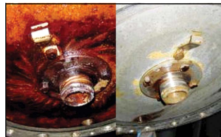
Bouchon cuve contaminée
