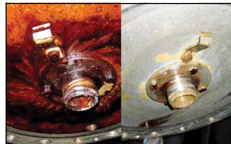
Bouchon cuve contaminée
