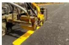
5 бар: нанесение дорожной разметки
